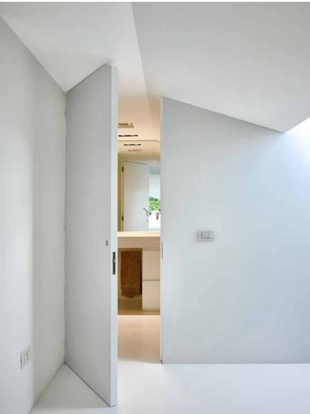
Porta per accesso al bagno, sagomata, per seguire l'andamento del soffitto mansardato. Finitura laccato bianco opaco.
