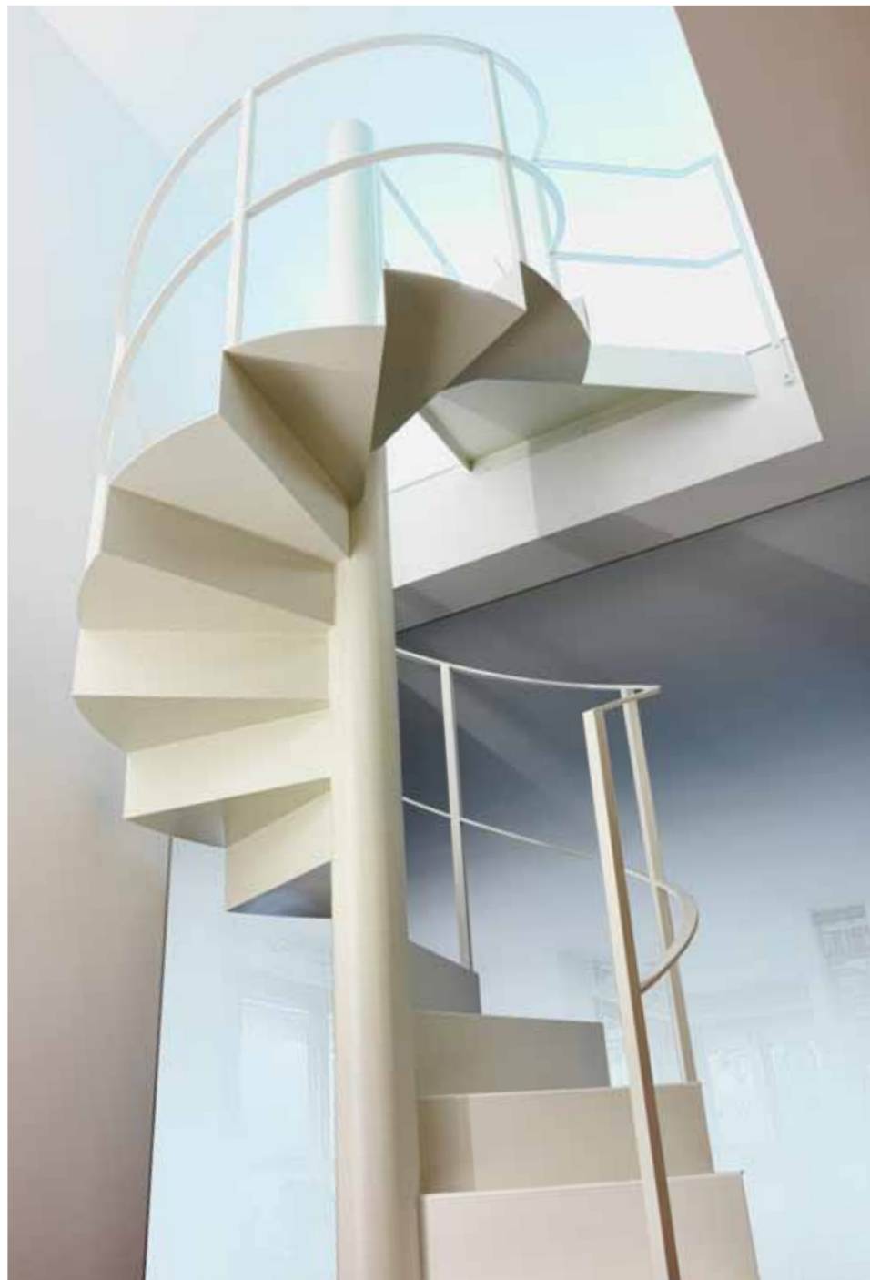
Scala elicoidale autoportante, dalle linee essenziali e di design, realizzata sul posto, in metallo verniciato bianco con parapetto sagomato in tinta.
