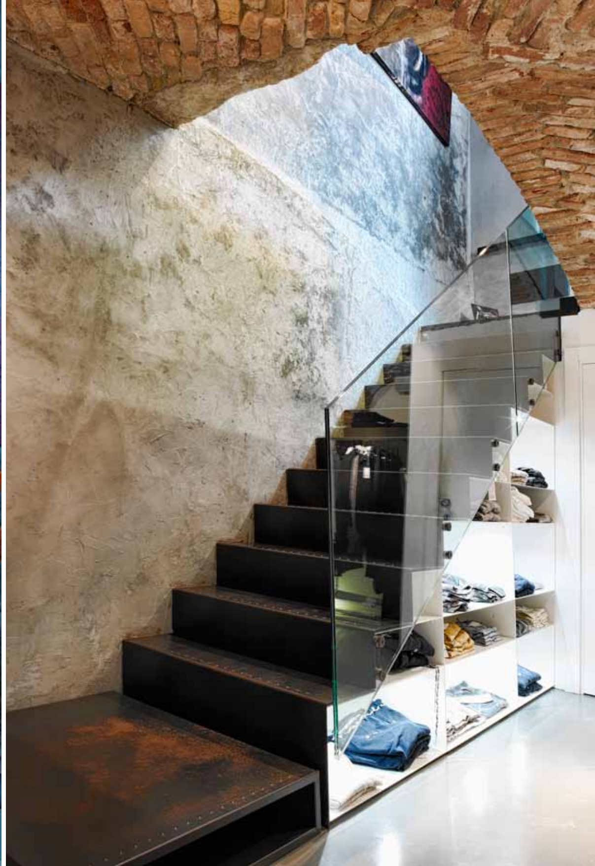
Scala realizzata per l'accesso al piano superiore del negozio, completamente in lamiera piegata, con il vetro trasparente che funge da parapetto e permette l'inserimento di un espositore nella zona sottostante.
